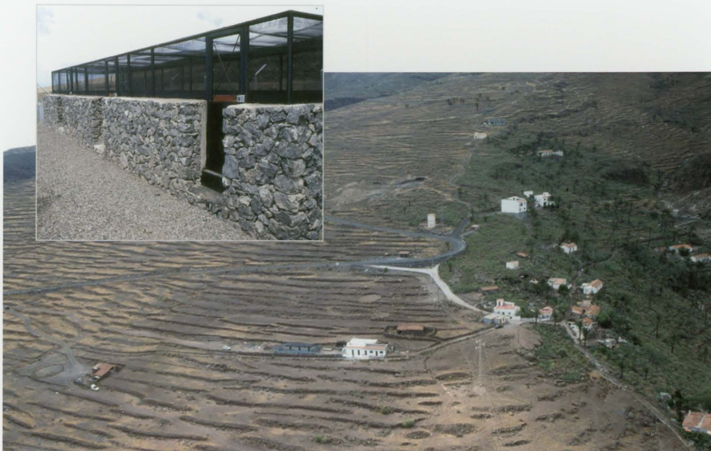
Instalaciones de Lagartario en ANTONCOJO.
