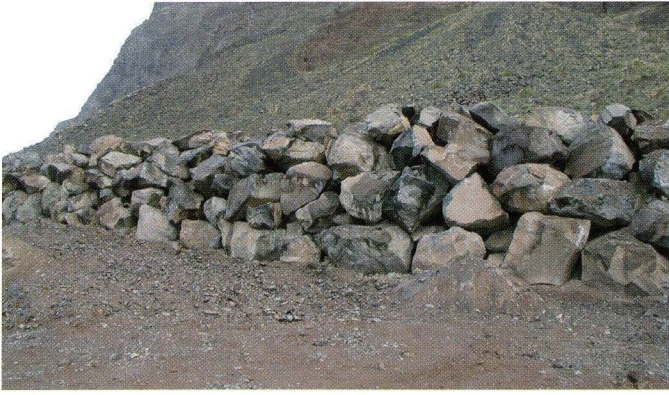
DIQUE DE PROTECCIÓN
