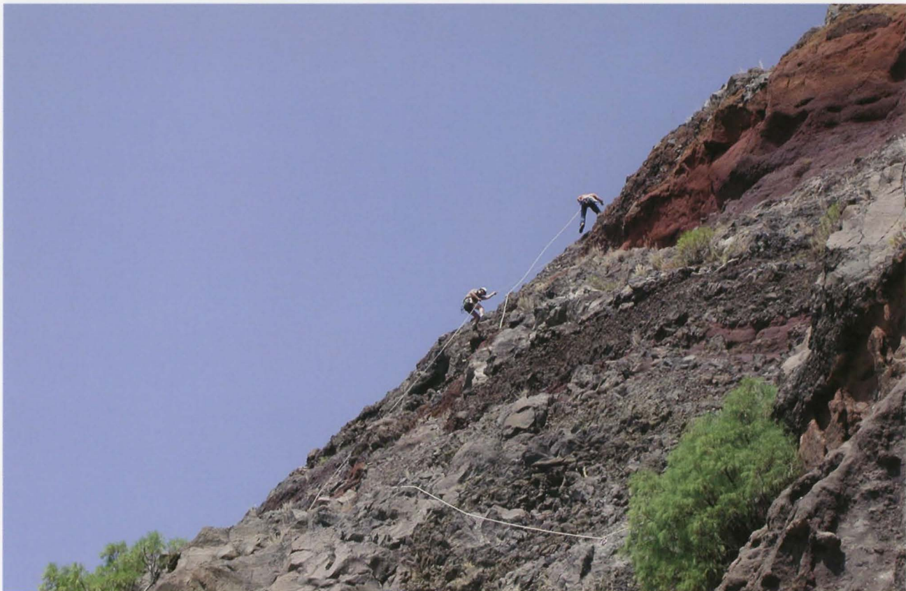
TRABAJOS EN EL ANDÉN EL CONEJO.
