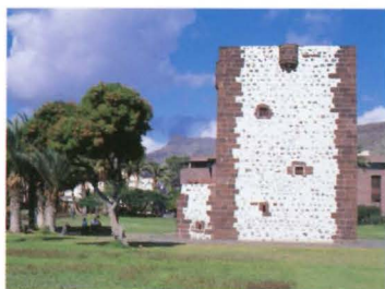
TORRE DEL CONDE, SAN SEBASTIÁN DE LA GOMERA
