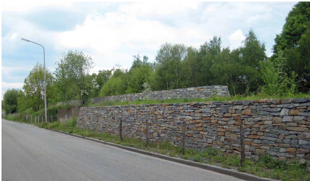
Figuur 2: Nieuw leefgebied voor de muurhagedis langs spoortraject Maastricht - Lanaken. Beneden zijn de hoge stapelmuren - tegen het talud - te zien. Boven de lage stapelmuren - in de spoorwegberm. Foto J. Hermans (2009)
