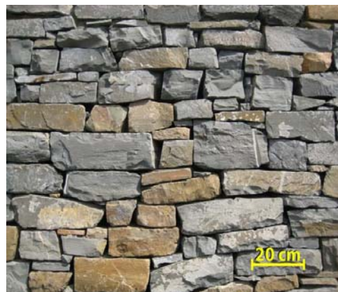
Figuur 5: Weergave van de bouwstijl van de stapelmuren. Duidelijk zijn de spleten te herkennen. Foto J. Hermans (2009)
