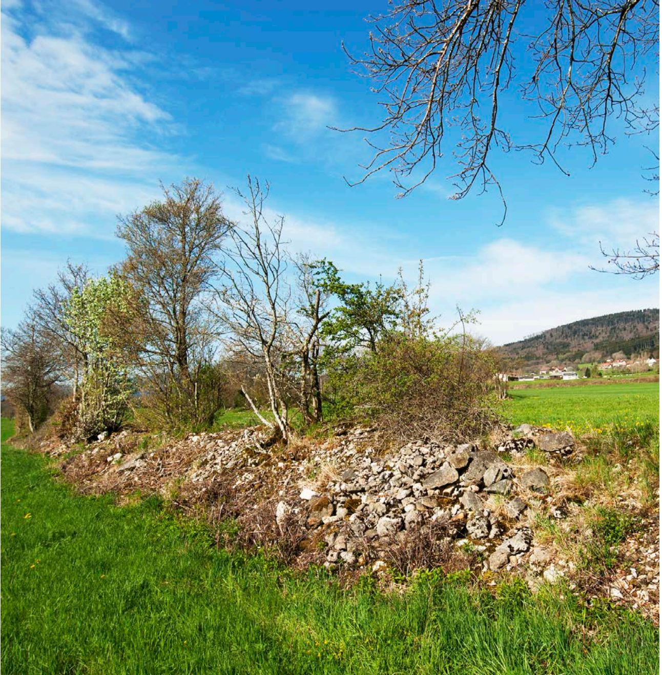
Als Vorbild für den Bau von Kleinstrukturen dienen immer die ehemals vorhandenen Elemente der ortstypischen, traditionellen Kulturlandschaft. Dieser Lesesteinwall ist ein Beispiel dafür.
