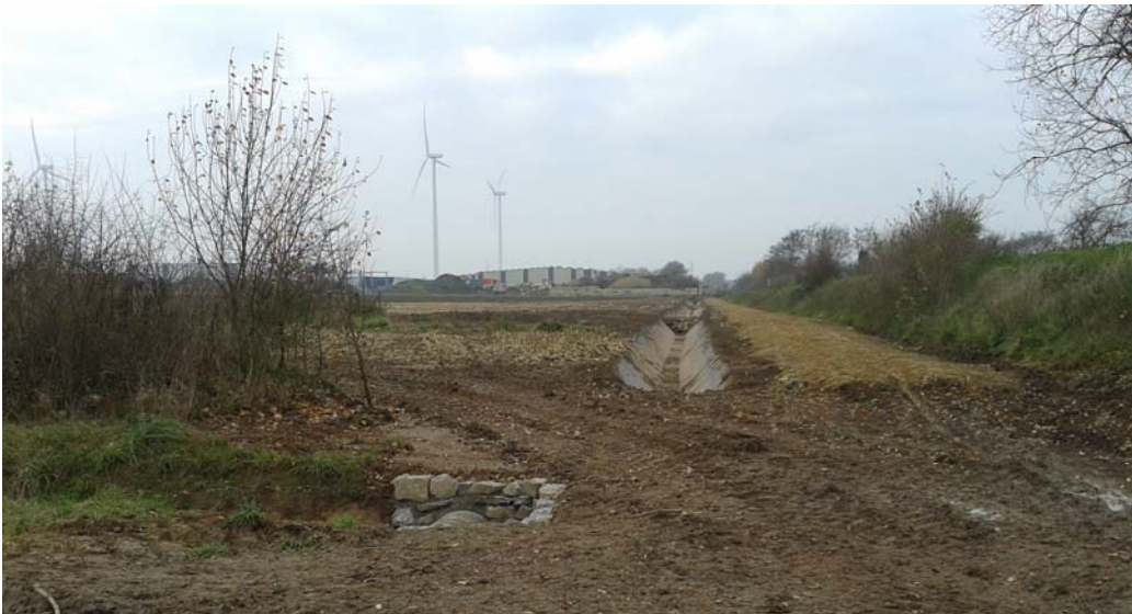
In december 2013 is de situatie hersteld, waarbij de sloot is verplaatst. De oorspronkelijke sloot is gedempt en afgewerkt met schraal zand en grind, zodat er een kruidenrijke, schrale vegetatie kan ontwikkelen (foto Prorail).
